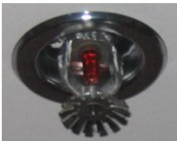
Erogatore sprinkler con elemento termosensibile a bulbo di vetro
